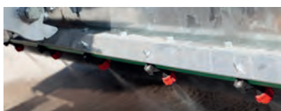
Szórószerkezet- a házhoz rögzített fúvókák vizet permeteznek, ezáltal megakadályozzák a por keletkezését
