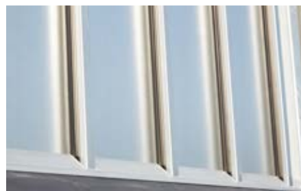
De profielvullers voorkomen vervuiling van de zijwandsegmenten
