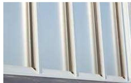
Les profiles caoutchouc empêche les salissures des ranchers de caisses.
