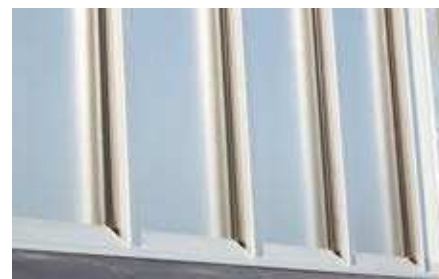
Výplně profilů zabraňují znečištění bočních segmentů.
