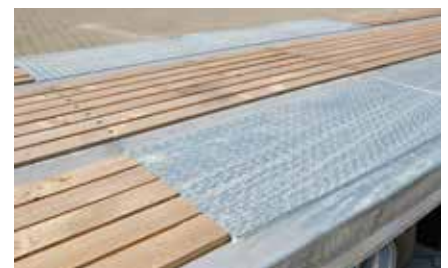
Auffahrrampen und Brückenboden aus Weichholz
