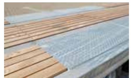
Auffahrrampen und Brückenboden aus Weichholz
