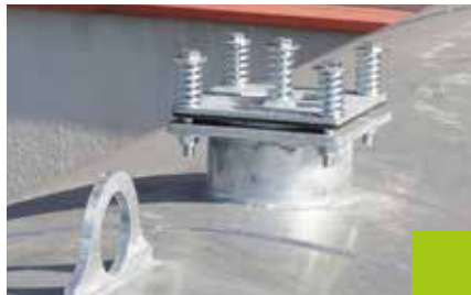
Über-/Unterdruckventil
