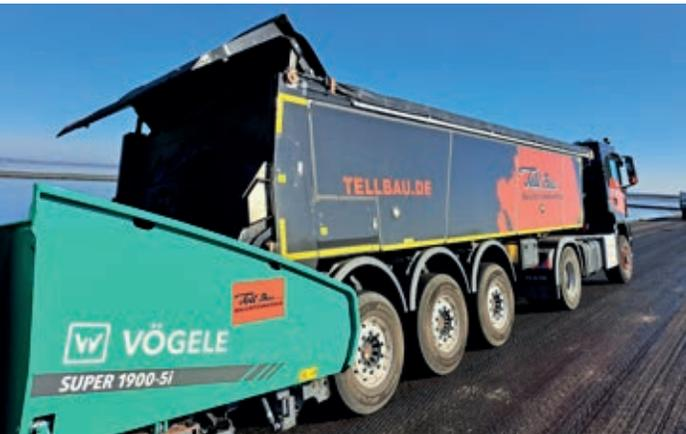
Durch die Fliegl-Abschiebetechnik kann der Lastwagen von Tell Bau das Asphaltmischgut sicher abladen. Kipplaster könnten am geneigten Deich leicht umfallen.
