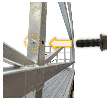
Illustration 44 : mise en place de la connexion vissée
