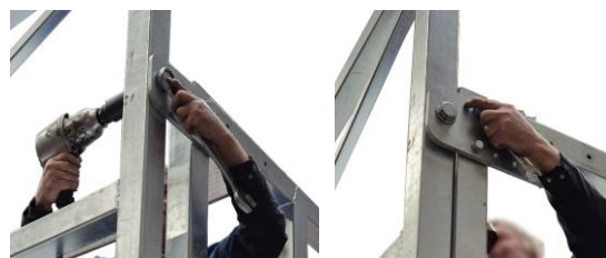
Illustration 44 : mise en place de la connexion vissée
