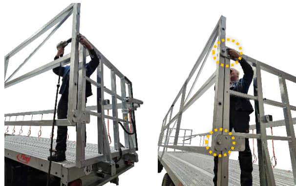
Illustration 41 : mise en place des connexions vissées
